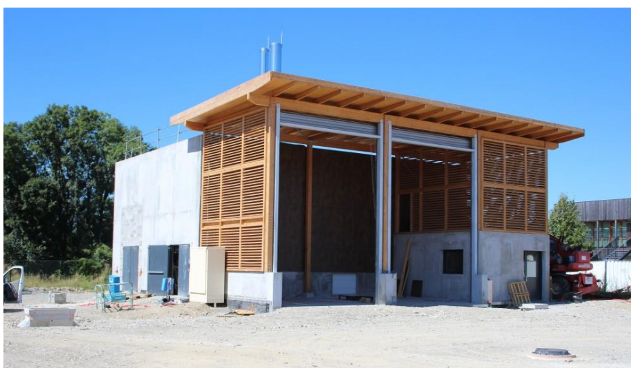
Chaufferie bois – Reignier © http://www.geronimo-architectes.fr/chaufferie-bois-reignier-esery
