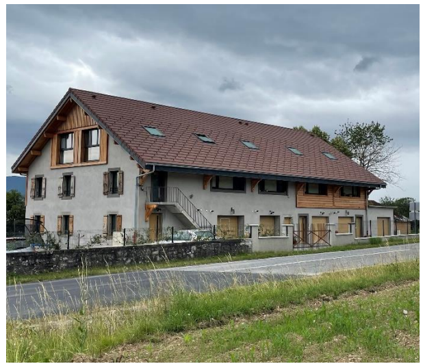
Rénovation d'une ferme sur la commune de Contamine-sur-Arve
