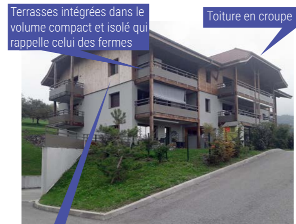
Bardage bois en partie supérieure de la façade
