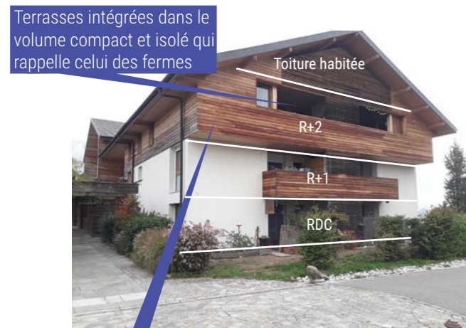
Un bâtiment qui profite du grand paysage
