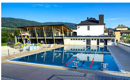
Piscine intercommunale © Boège.
