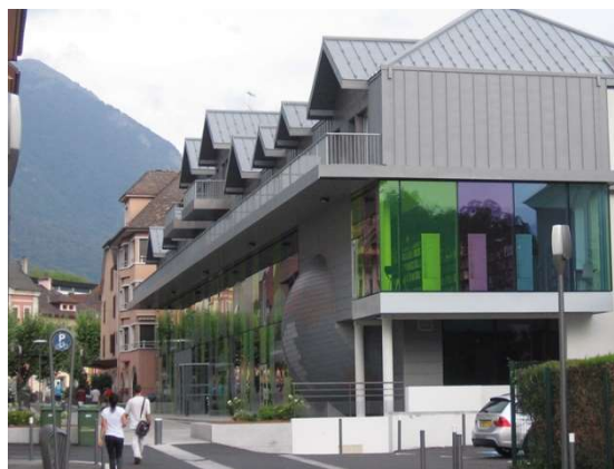
Médiathèque intercommunale Henry Briffod © Mairie de Bonneville.
