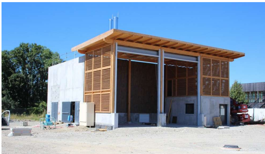
Chaufferie bois – Reignier © http://www.geronimo-architectes.fr/chaufferie-bois-reignier-esery
