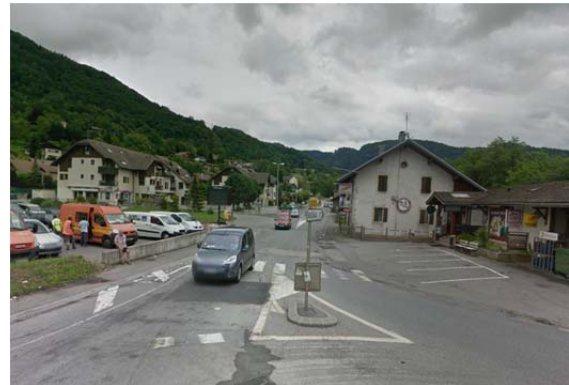
Photo n° : Pont de Fillinges Source : EPODE
