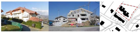
Figure 52 : Habitat en petit collectif sur le territoire des 3 Vallées, Source : photo Epode, cadastre impôts
