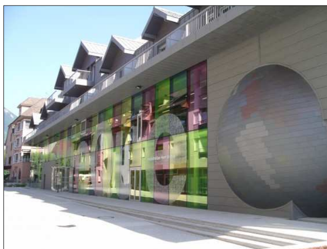
Crédit photo : CCFG 2009 – Construction de la médiathèque intercommunale 2008/2009
